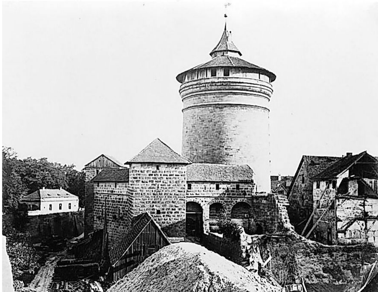
Dass es Zeiten gab, da Teile der Nürnberger Stadtmauer - wie hier am Laufer Tor 1890 - abgerissen wurden, ist heute kaum mehr vorstellbar. Vielmehr geht es darum, die für Nürnberg noch immer prägende Befestigung zu erhalten.
